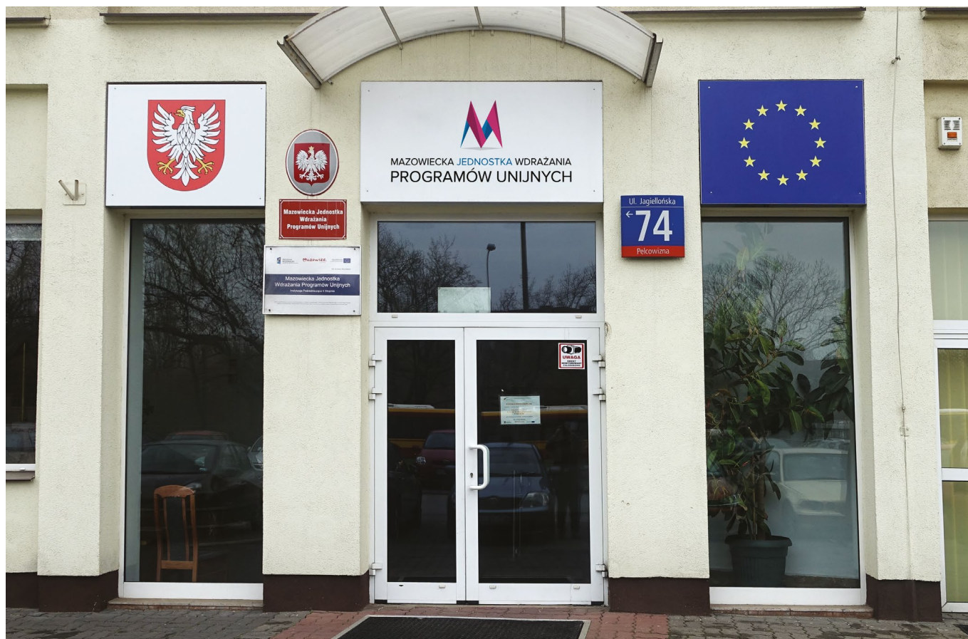
Przykład oznakowania budynku
